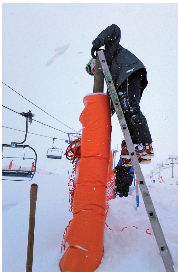
Figura 4. Los días de riesgo 5 de aludes no se abre la estación por seguridad, pero los pisters siguen trabajando en la parte baja de la estación para reparar redes o subir colchones de protección que hayan podido quedar enterrados, en el caso de que haya nevado mucho.
